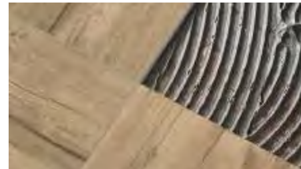
Laying on screed with adhesive. Colocación con adhesivo.
