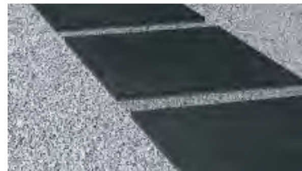
Dry laying on gravel and sand. Colocación sobre piedras.
